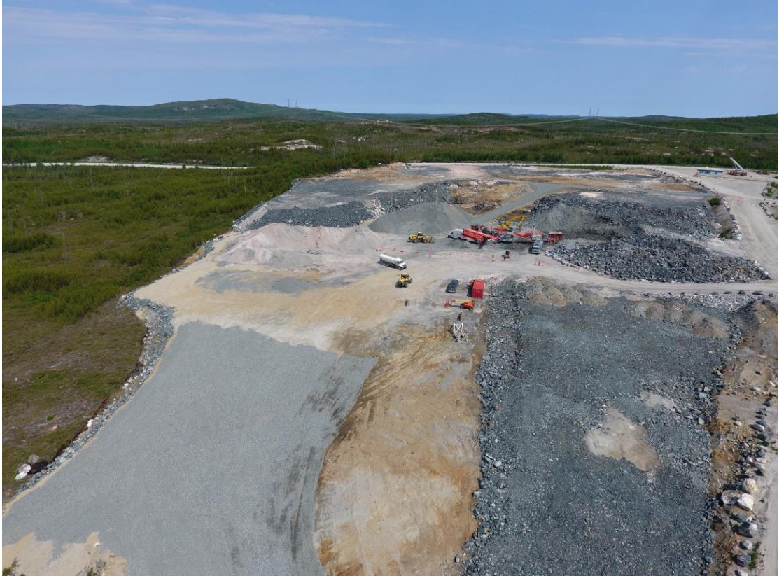
Les travaux civils pour le garage et l'aire d'entretien du site minier Whabouchi sont en cours.
