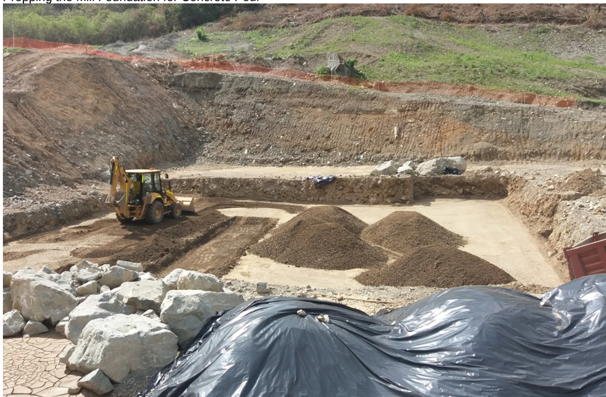
Prepping the Mill Foundation for Concrete Pour
