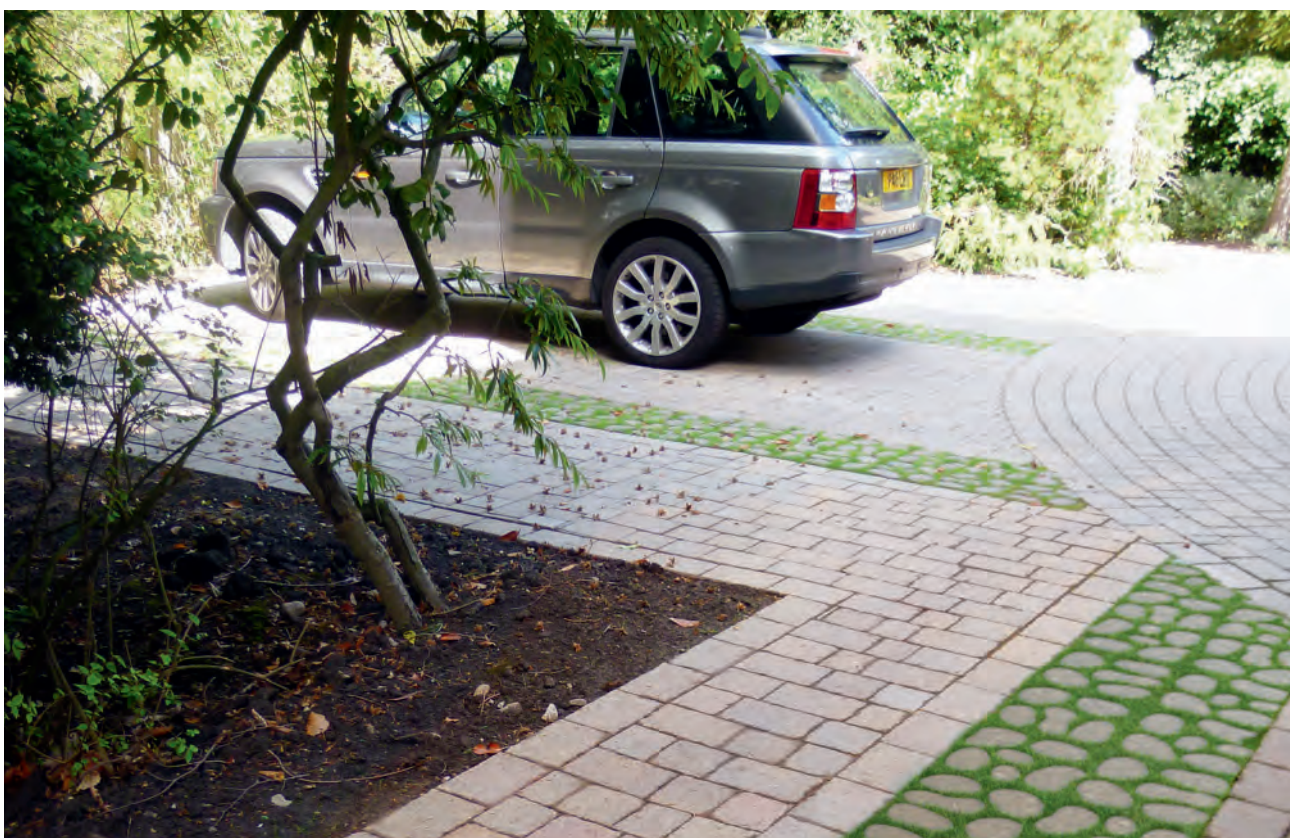
Biodiverse Permeable Paving
