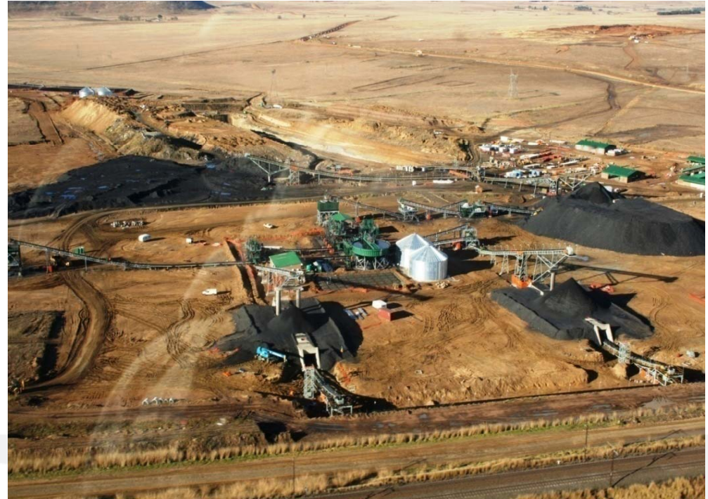
Aerial view of Mooiplaats Colliery
