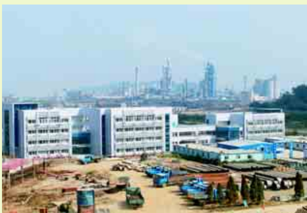
蘇能垃圾焚燒發電廠（生活樓在建中）
