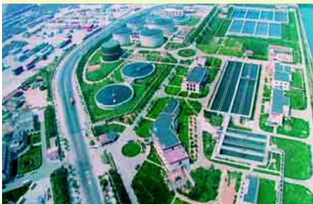
青島海泊河污水處理廠
