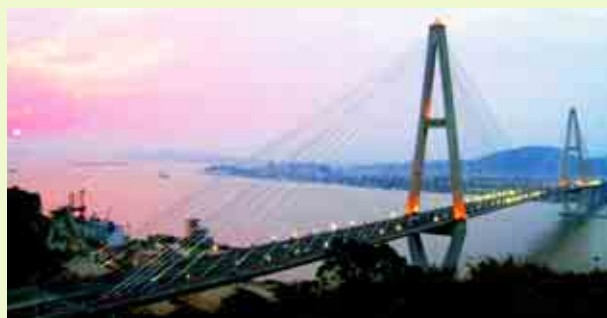
福州青洲大橋 Fuzhou Qingzhou Bridge
