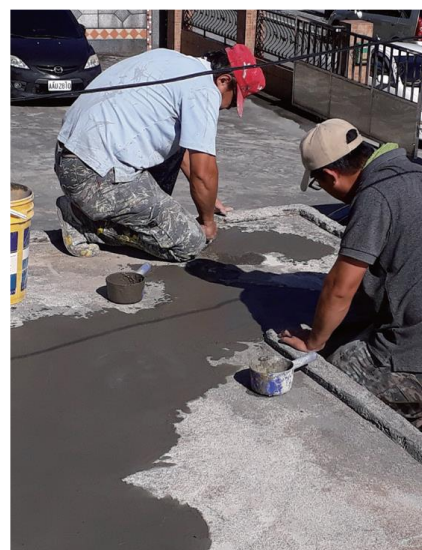
社區房屋修繕
