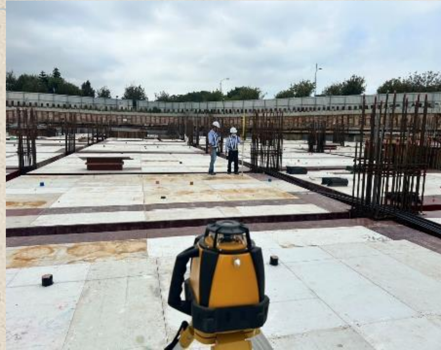
B1FL模板施工品質 版面高度查核
