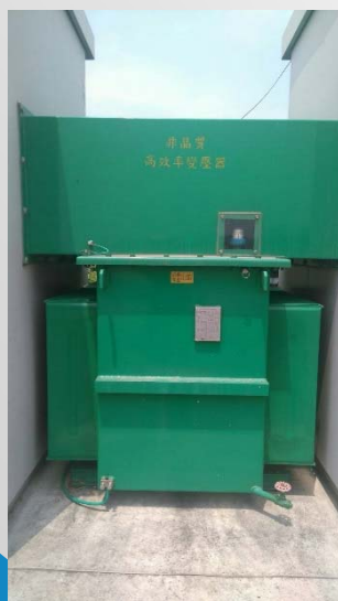
24kV 油浸式非晶質變壓器
