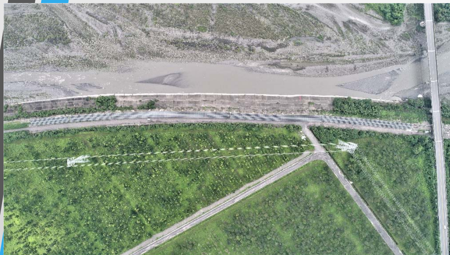
屏東縣大響營堤防-空拍圖 (太陽能地面型案場)
