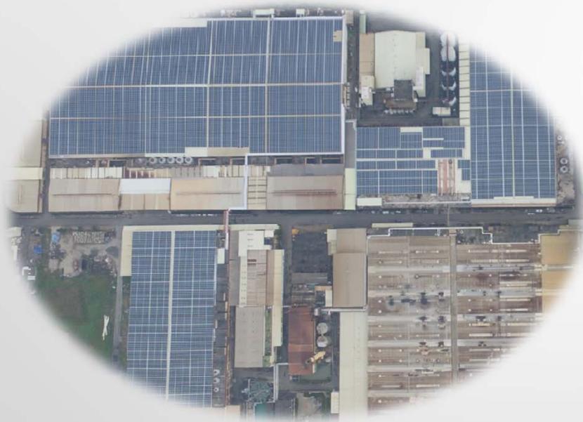
台南7.5MW屋頂型電廠
