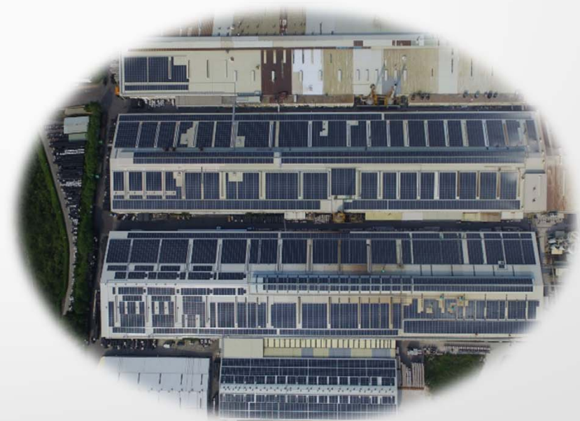
苗栗4.0MW屋頂型電廠
