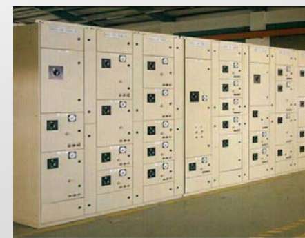
600V馬達集中控制盤(M. C. C)
