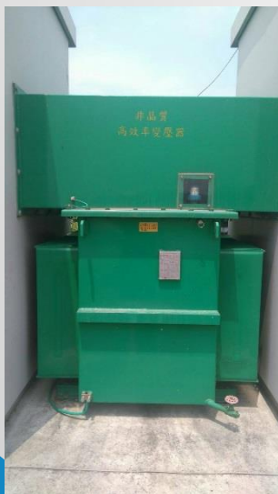
24kV 油浸式非晶質變壓器
