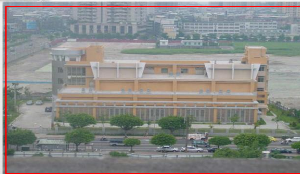
台北七張變電所
