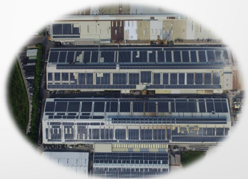
苗栗4.0MW屋頂型電廠
