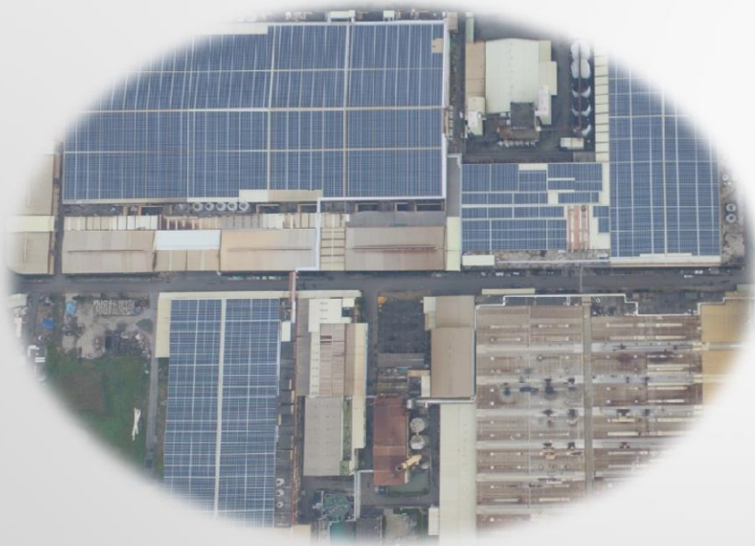
台南7.5MW屋頂型電廠
