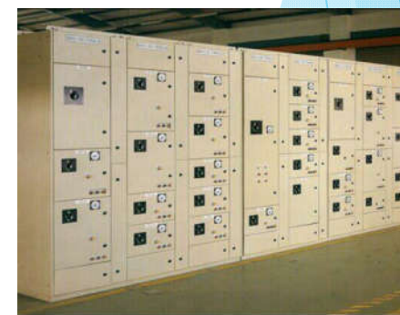
600V馬達集中控制盤(M. C. C)
