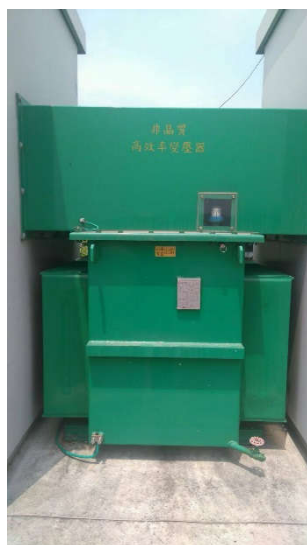
24kV 油浸式非晶質變壓器
