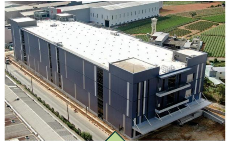
龍潭智能園區-A棟倉庫
