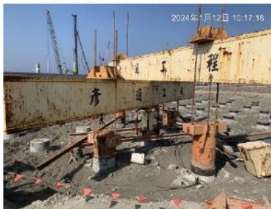
【儲槽T-3309壓力載重試驗】
