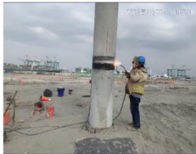
【儲槽T-3317基樁銲接】
