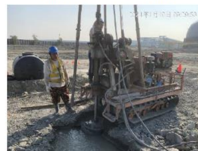
【儲槽T-3306固定液鑽心取樣】
