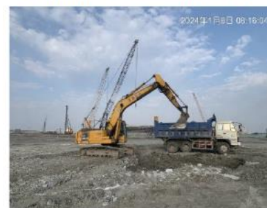
【儲槽T-3308基樁開挖】
