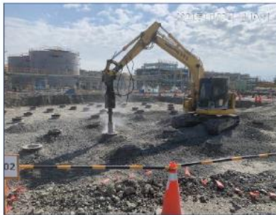
【儲槽T-3302樁頭處理】
