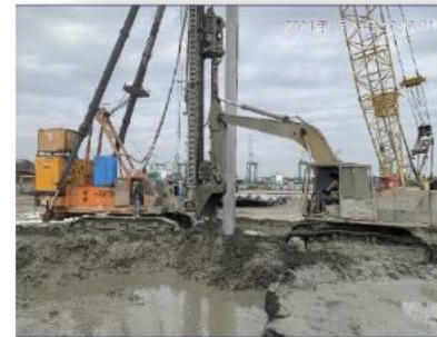
【儲槽T-3317植樁】
