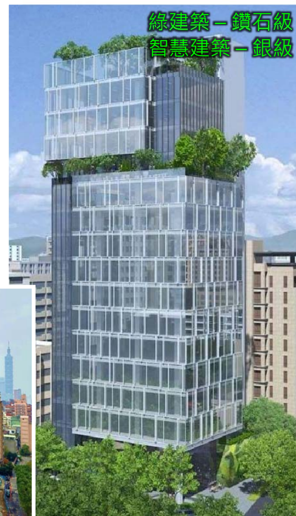
寶紘敦南商業大樓
