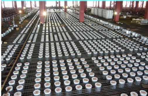
Grid Precast waffle slab
