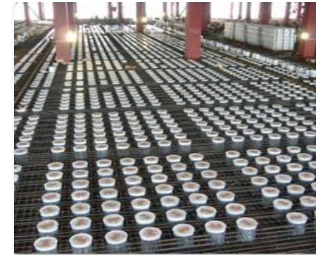
Grid Precast waffle slab
