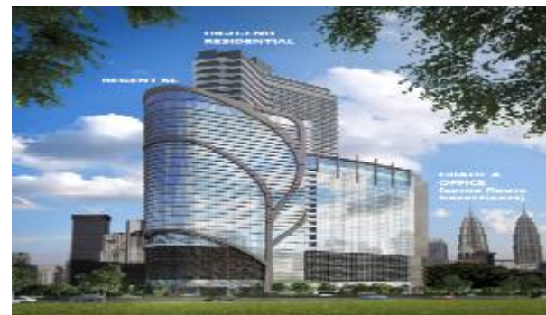
吉隆坡 KUALA LUMPUR (2025) 250間房間和套房
