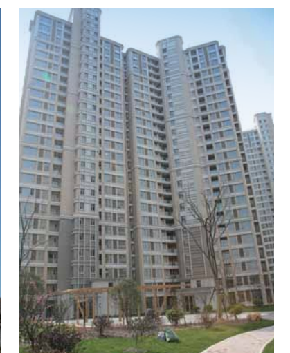
▼ 2012 上海嘉定·伯爵天地 竣工交屋 建築面積：94,097平方米
