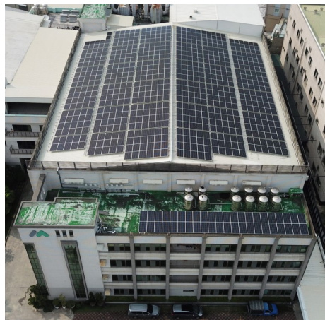
懋莉(台南) 226kWp
