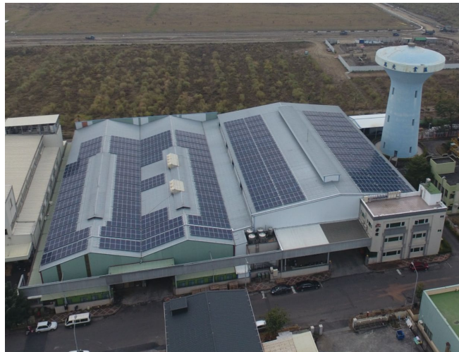
榮銓(高雄) 334kWp
