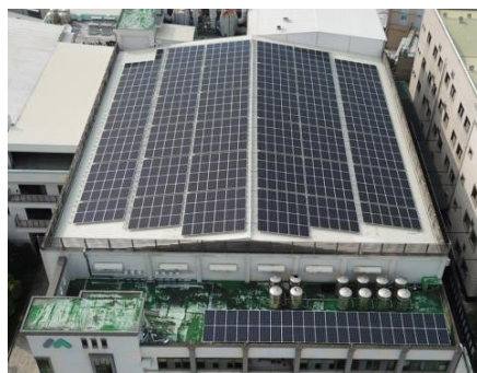
懋莉(台南) 226kWp
