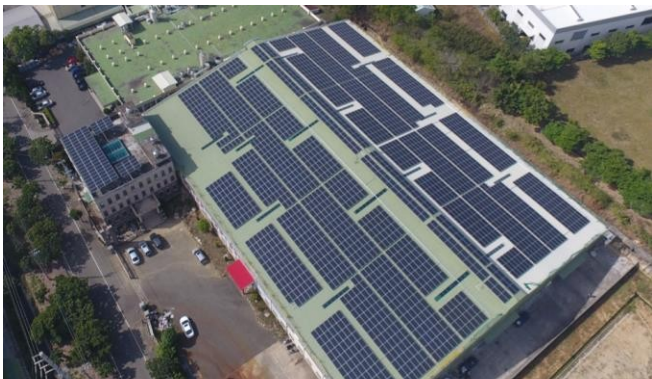
進興(嘉義) 749kWp
