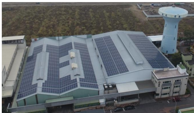
榮銓(高雄) 334kWp
