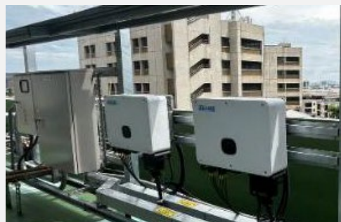
PV 103.24kWp Billion Giga-40-60K 光電變流器
