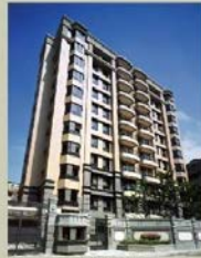
2001 金山路／昇陽大廈 1999年中華建築金石獎 2001年國家建築金獎 施工品質全國首獎
