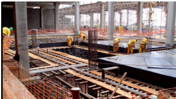
Obras do Projeto do Boulevard Londrina
