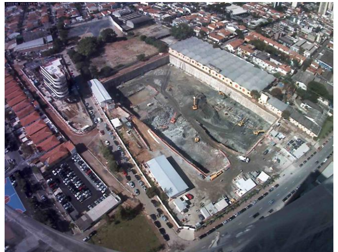
Obras EZ Tower - 04.05.2012
