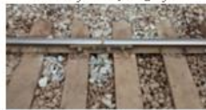
Recuperação de junta
