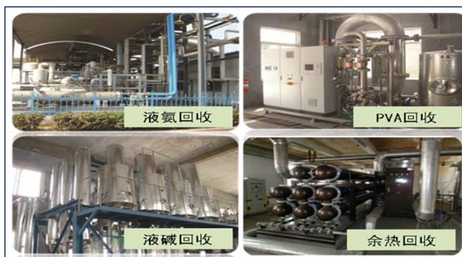
图 25 采用国际先进技术、实现节能减排
