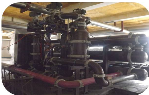
图 26 采用国际先进技术、实现节能减排
