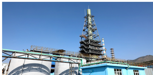
▲ 4 月 18 日,易门铜业硫酸分厂新建环集烟气脱硫项目主体工程已建成,全面进入单机试车、系统联动调试阶段
