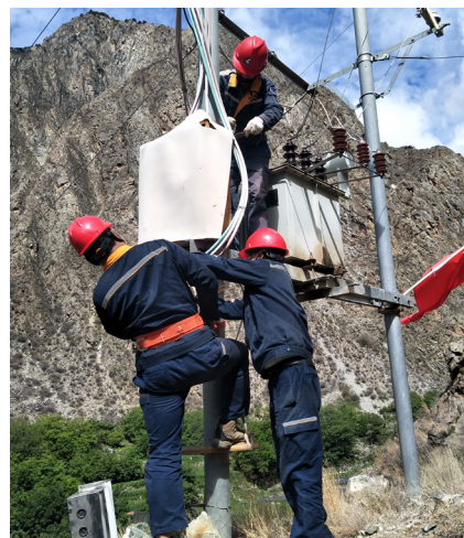
▲ 帮助鲁农村村民更换老化电线和电器设备
