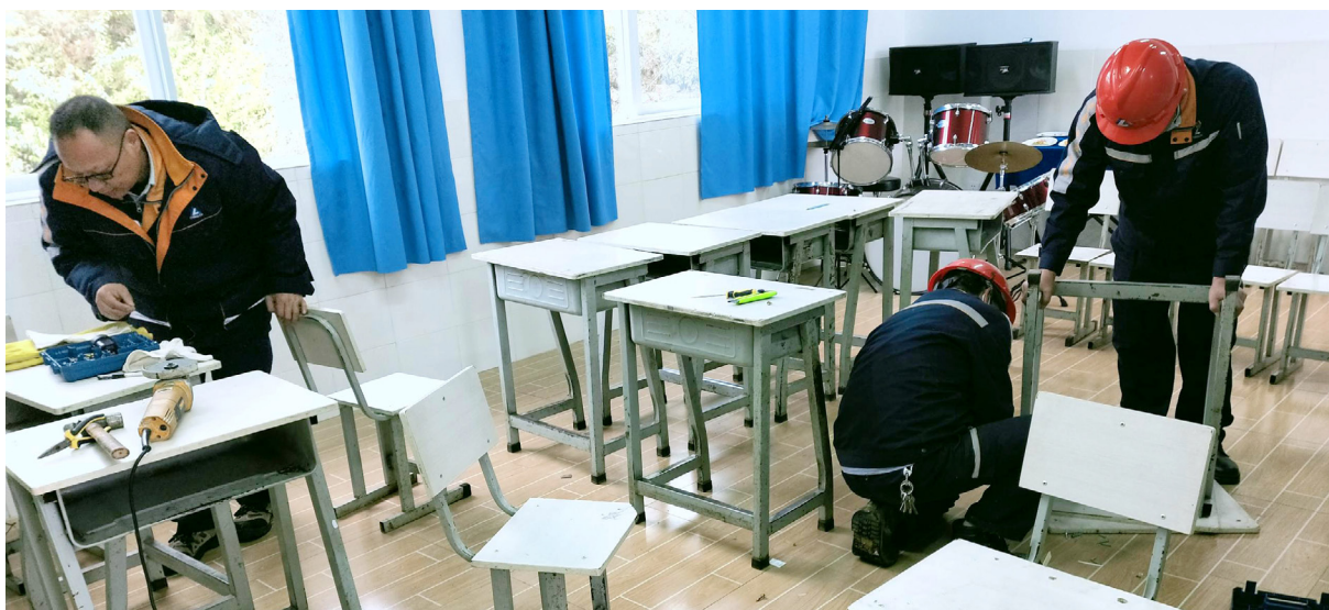
▲ 易门铜业组织党员到罗台旧小学安装电灶、维修课桌、更换老化水管
