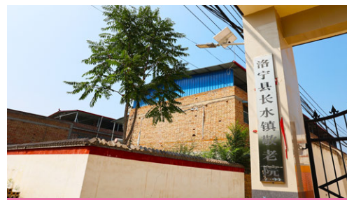
为洛宁县长水村安装太阳能路灯
