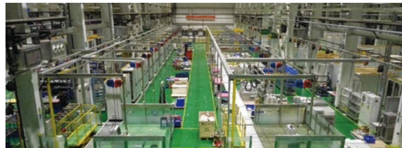
天诚同创实施变流柜流水线项目，缩短了制造周期，降低作业人数，有效提升了生产效率
