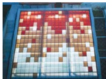
大厦下沉广场安装10%透光的薄膜光伏组件
