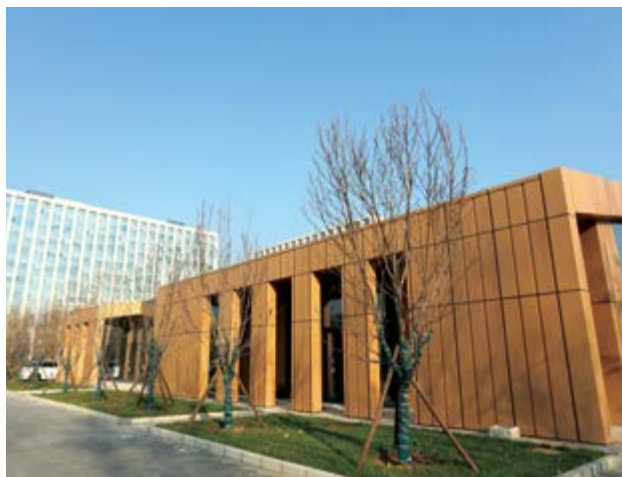
公司北京总部二期园区污水处理系统
