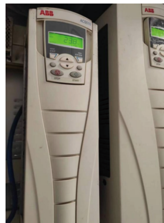
空调风柜电机变频改造，加装变频器装置
