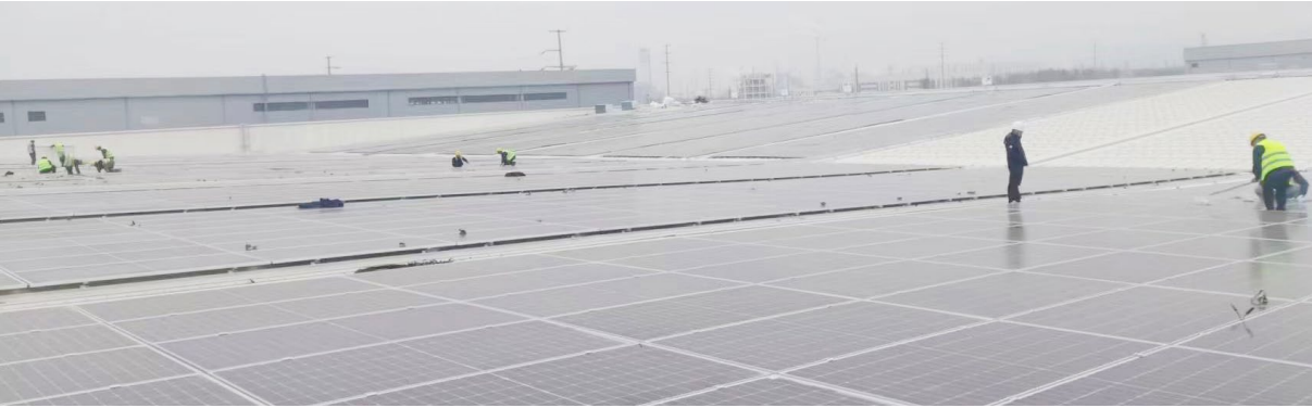
屋面光伏安装
