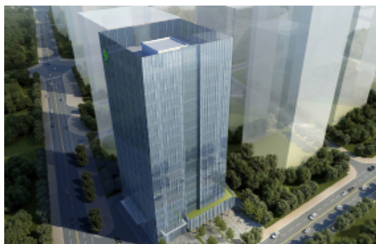
集团总部及技术中心（筹建中）
