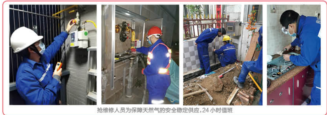
抢维修人员为保障天然气的安全稳定供应，24小时值班
