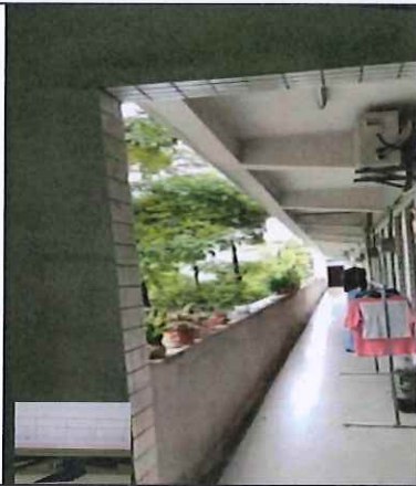
图片 9、估价对象 2 现状
