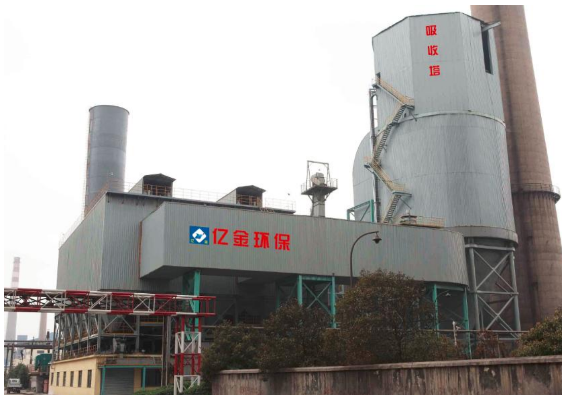
旋转喷雾半干法脱硫设备实景图
