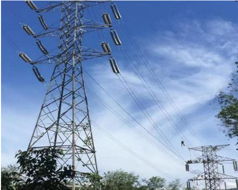
150kv输电线路架线施工中
