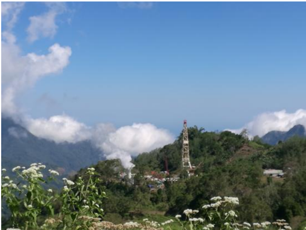
SGI项目现场图
