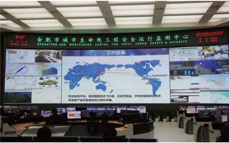
▶ 辰安科技承担合肥市城市生命线安全运行监测系统工程
