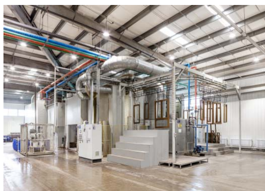
悬挂式自动喷涂线
