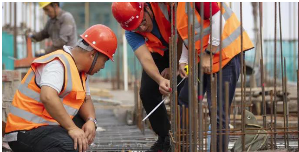
©精细化施工管理现场
