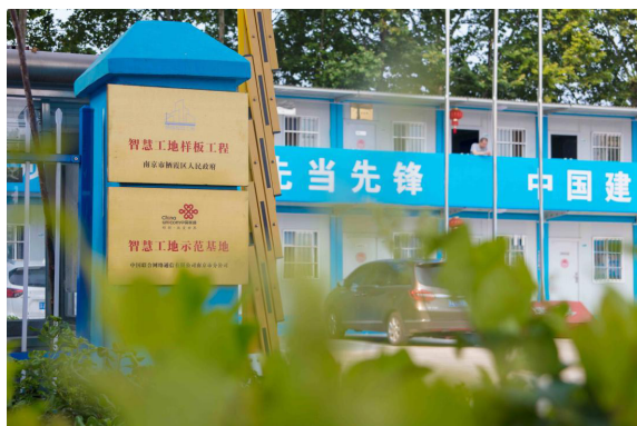
©项目获评智慧工地样板工程/示范基地
