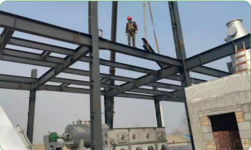
>> 项目吊装现场
