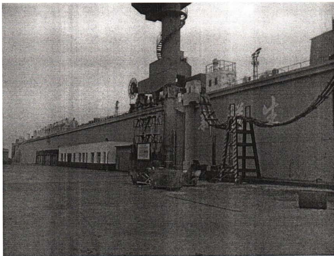
船坞及部分设备照片
