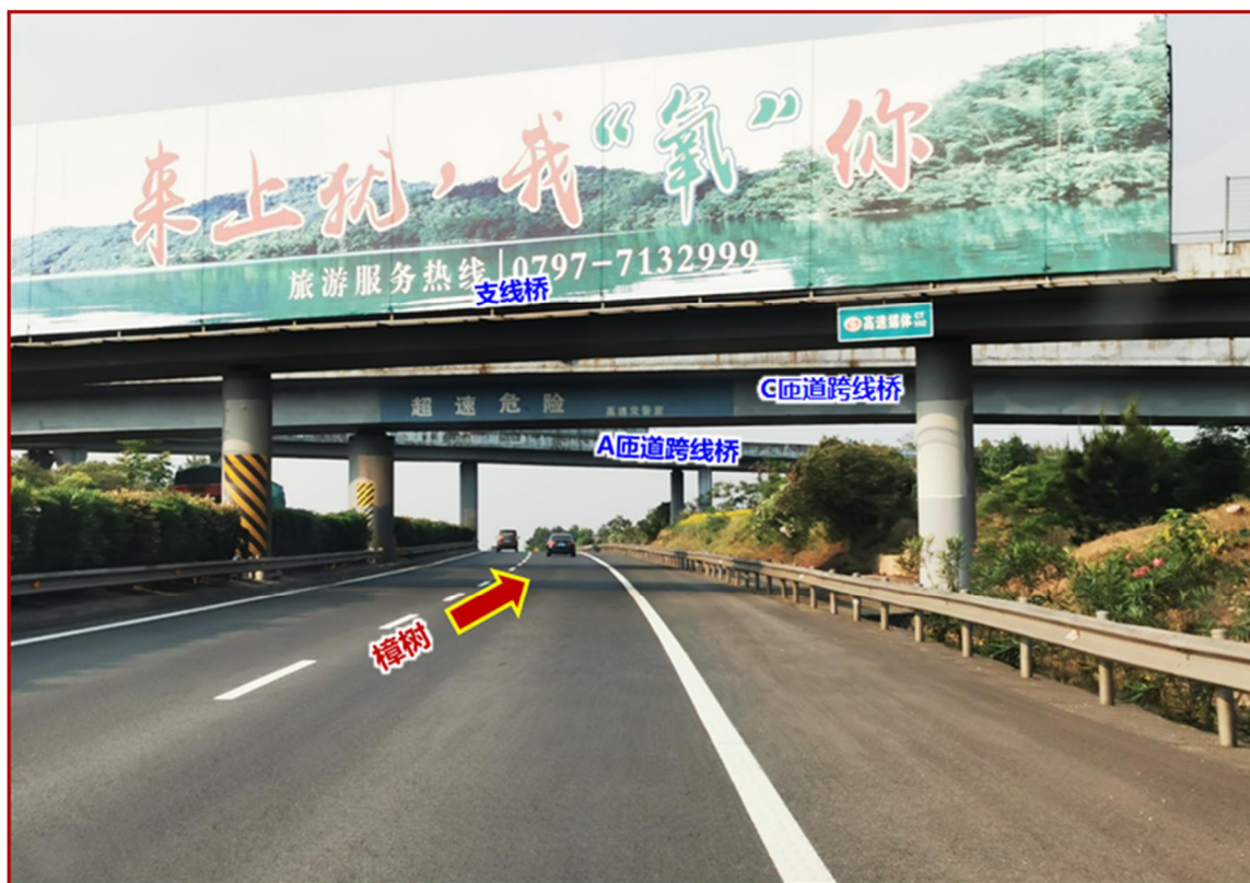
吉安北枢纽匝道、支线跨线桥
