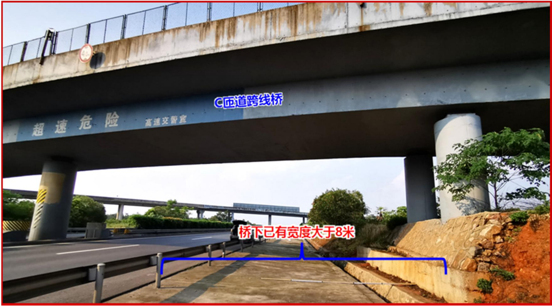
C 匝道跨线桥
