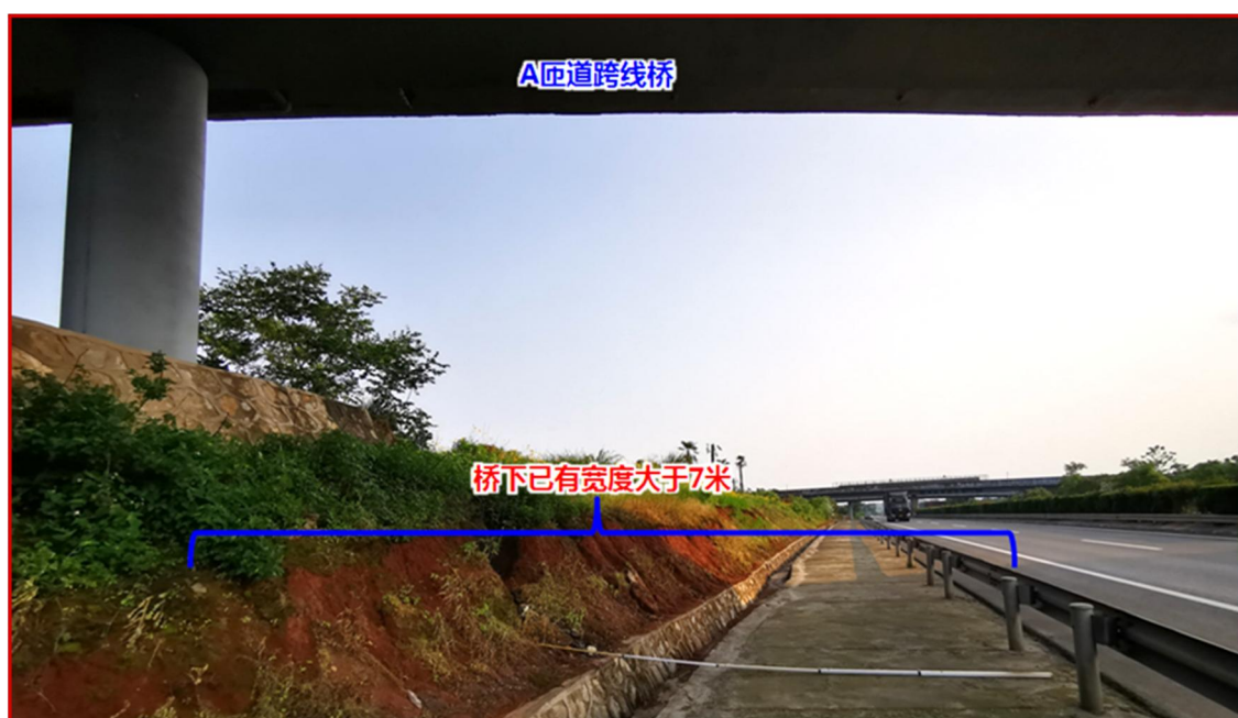
A 匝道跨线桥
