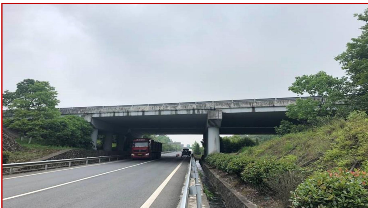
峡江互通主线跨线桥
