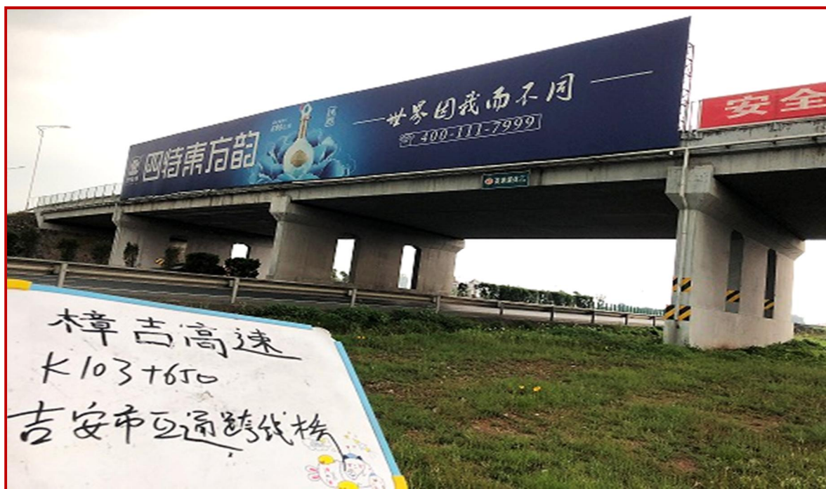
吉安南 A 匝道跨线桥
