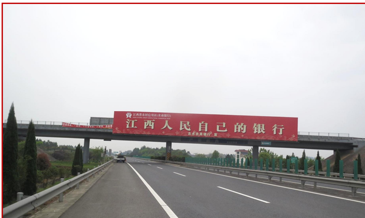
吉水互通 A 匝道跨线桥
