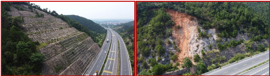
樟吉高速东侧锚索高边坡
