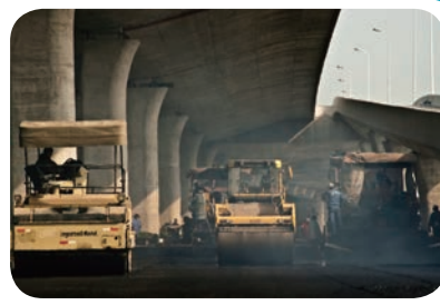
锦绣路中环匝道摊铺
