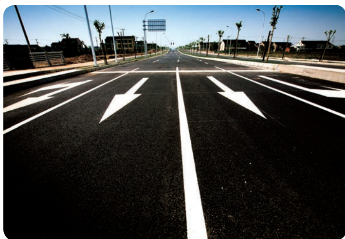
迪士尼工程项目唐黄路-航城路竣工（1）
