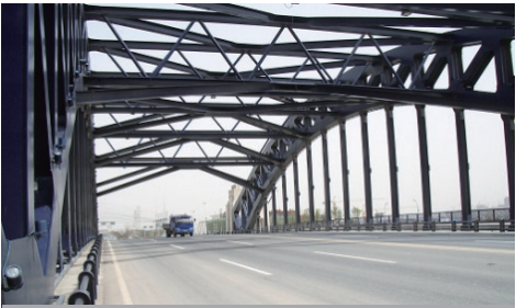
钢桥面沥青混合料铺装成果
