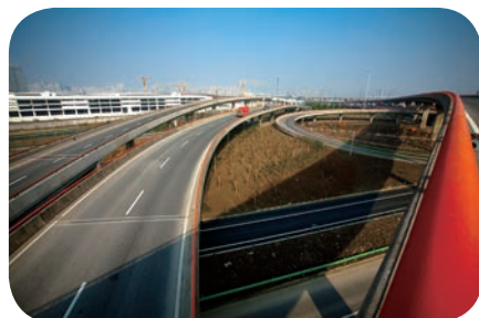
内环线浦东段快速路改进工程
