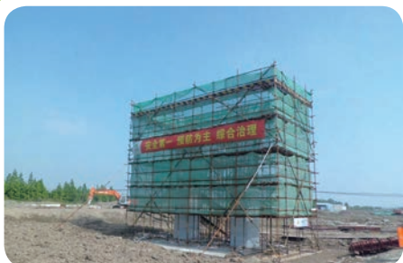
申江路（中环线—S2） 高架专用道在建工程1标
