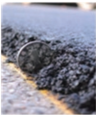
小粒径超薄层铺装技术
