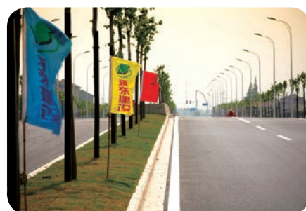
迪士尼工程项目唐黄路-航城路竣工（2）
