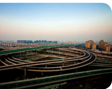
中环线浦东段（上中路越江隧道-申江路）工程6标
