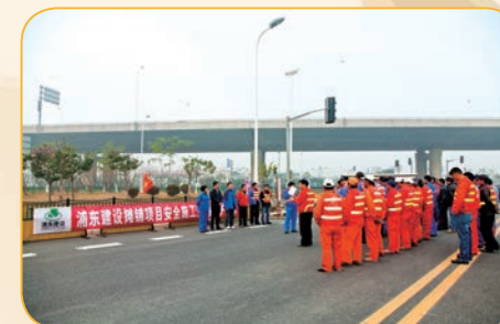
沥青产业事业部举行摊铺项目安全施工交通维护演练
