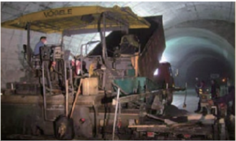
温拌沥青混合料（WMA）生产施工现场
