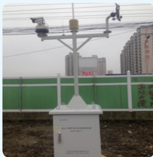
扬尘、噪声在线监测系统
