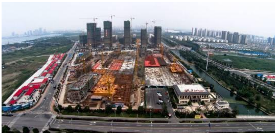
苏州山湖一号项目现场
