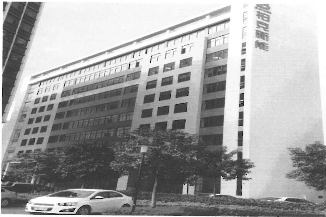
6 层厂房外观照片
