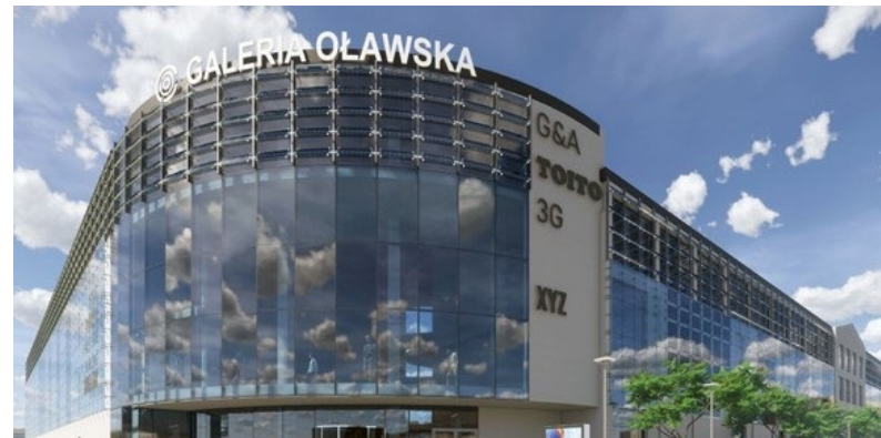
Rysunek 36. Fasada BIPV Galerii Oławskiej
