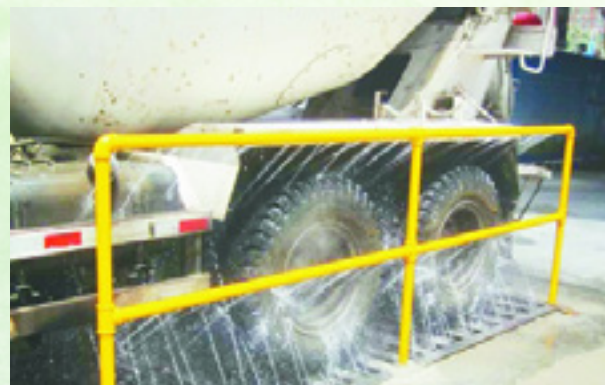
中核华兴苏宁电器项目——自制洗轮机
