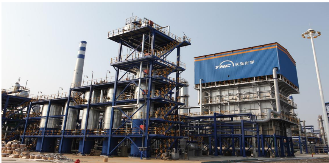
瑞泽石化设计制氢装置图
