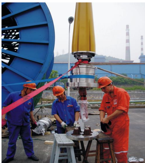
公司的动态脐带缆终端安装现场
